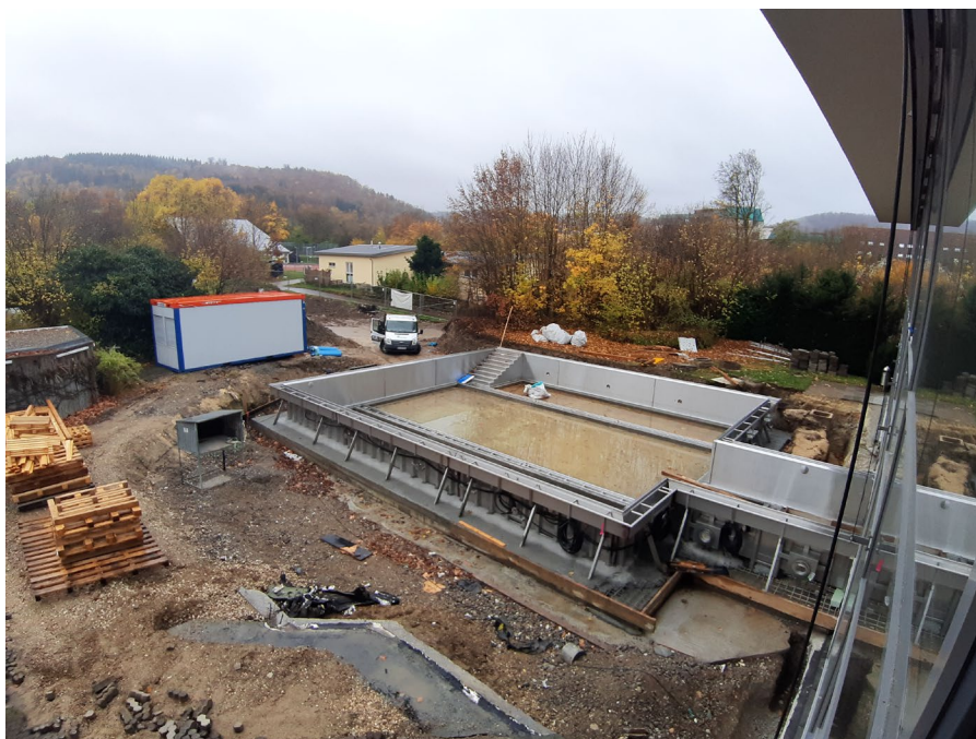
Baustelle für ein neues Edelstahlbecken und erneuerte Außenanlagen
