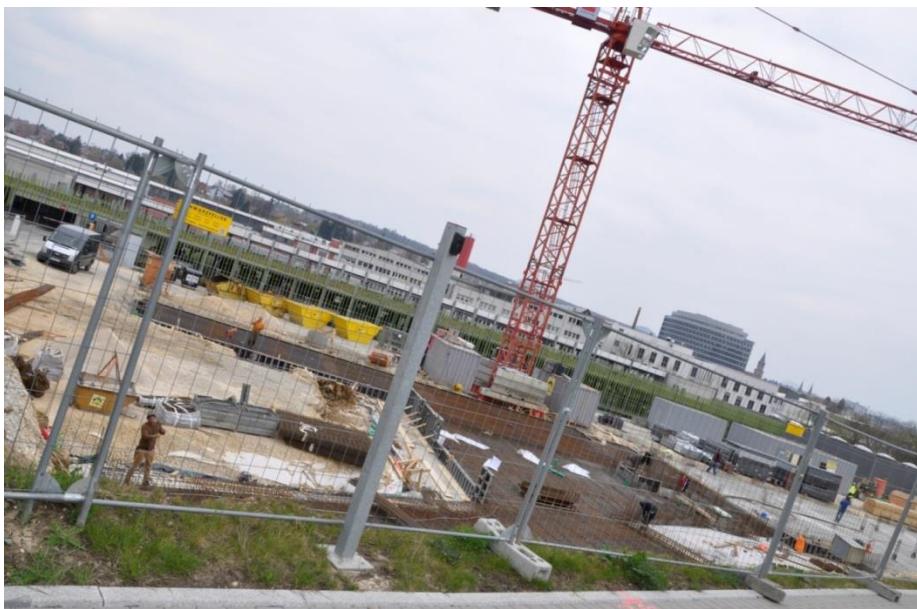
Bild 2: Blick auf den Neubau Haus 26 von der Christophsbad-Allee
